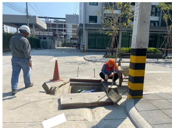
รูปที่ 17 ช่างเข้ามาทำความสะอาดท่อระบายน้ำ พื้นที่โครงการ
