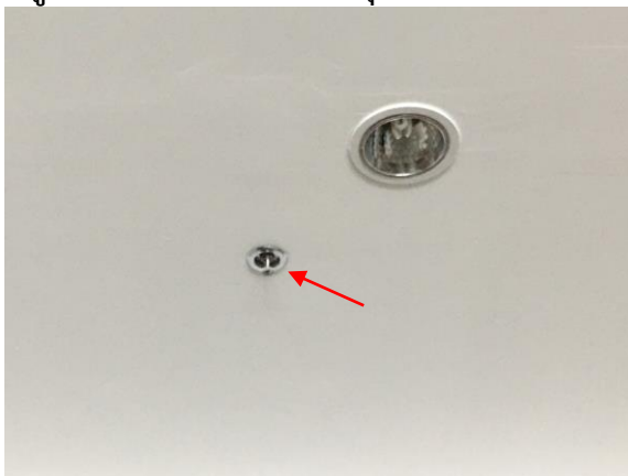
รูปที่ 11 ระบบกระจายน้ำดับเพลิง
