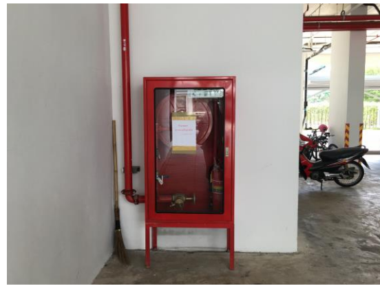
รูปที่ 10 ตู้เก็บสายฉีดน้ำดับเพลิงรูป
